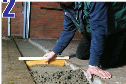
Coloque una base de concreto de 10 cm, si es necesario corte los canales a la longitud requerida.
