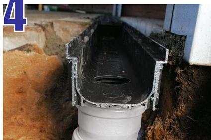
Interconecte el adaptador para descarga con la tubería (que puede ser de 3" o 4" cédula 40), o use un adaptador flexible de 4" si el espacio lo permite. A partir de este punto, se puede colocar el resto de los canales.
