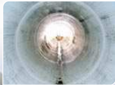
Vista dentro del tubo de concreto con recubrimiento interior ya instalado.
