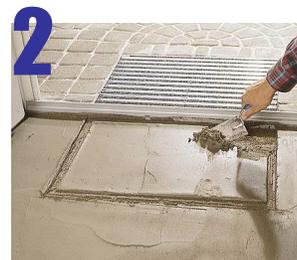
2 Excave un área lo suficientemente amplia para colocar la base *DrainMat*.
