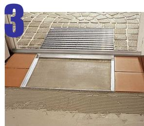
3 Asegúrese que la base *DrainMat* quede 3 mm por debajo de la superficie del pavimento para evitar tropezos.
