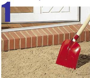
1 Excave un área lo suficientemente amplia para colocar la base *DrainMat*, compacte un estrato de 5 cm de arena antes de colocar la base.
