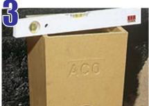
Coloque el registro PointDrain sobre un encamado de concreto de 10 cm, y revise sus niveles
