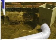
Excave un espacio apropiado para colocar el registro PointDrain y las tuberías de descarga
