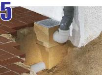
Coloque el elevador (si es necesario); puede conectar una tubería de descarga al elemento. Vacíe el concreto de relleno y rehabilite el pavimento de la superficie
