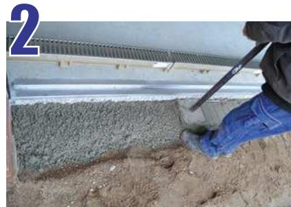
Vierta la cama de concreto – 30 cm de ancho por 10 cm de profundidad. Mantenga limpio el tubo de salida.
