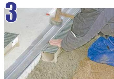
Coloque los canales a partir del punto de descarga. Revise continuamente los niveles; acople y selle las uniones.
