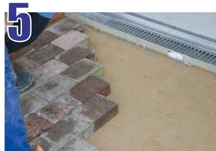
Coloque los adoquines o el pavimento al nivel requerido. Debe estar 3 mm por encima de la rejilla.
