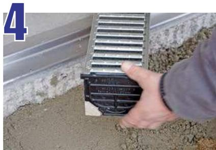
Coloque las tapas en los extremos, y las rejillas. Proteja las rejillas con cinta para evitar ensuciar el interior del canal.
